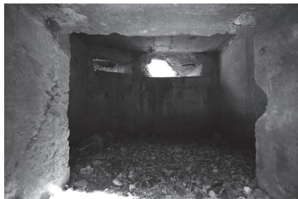
沖縄戦の激戦地・嘉数高台公園(宜野湾市)に残る、日本軍が築いたトーチカ(コンクリート製陣地)。(©OCVB)
